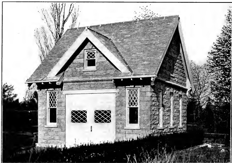
Concrete Block Garage, Paterson, N. J.
