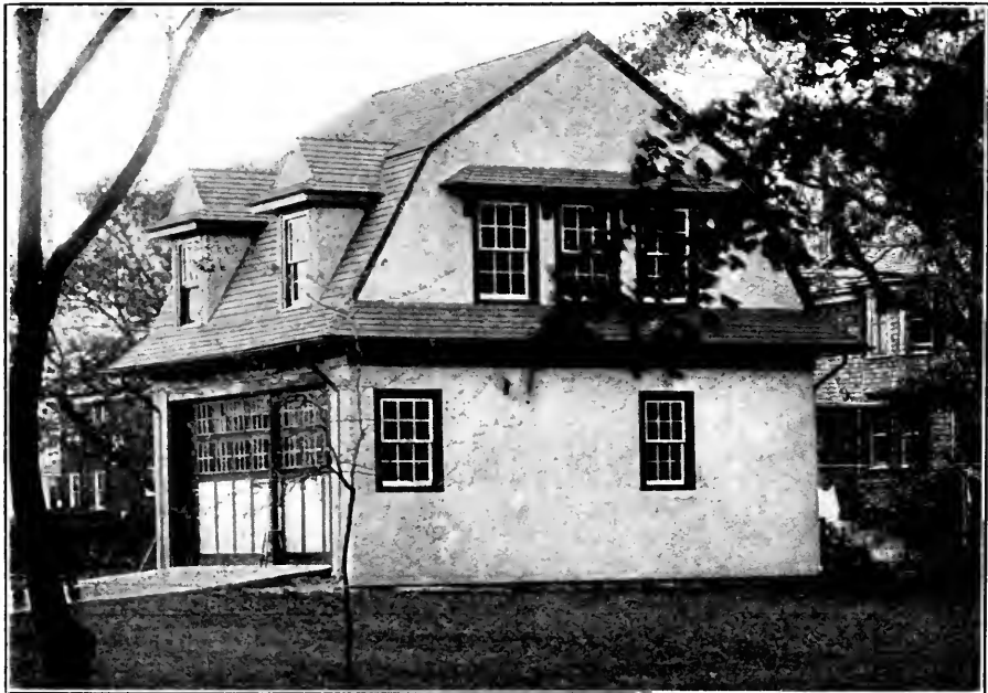
Stucco Garage, Far Rockaway, L. I.
