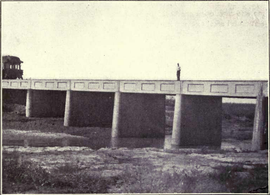
FIG. 22.—PIER TRESTLE, C. & Q. R. R.
