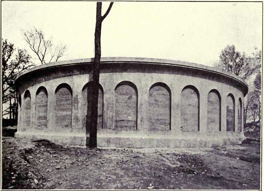
FIG. 119.—COS COB STORAGE RESERVOIR, N. Y., N. H. & H. R. R.
