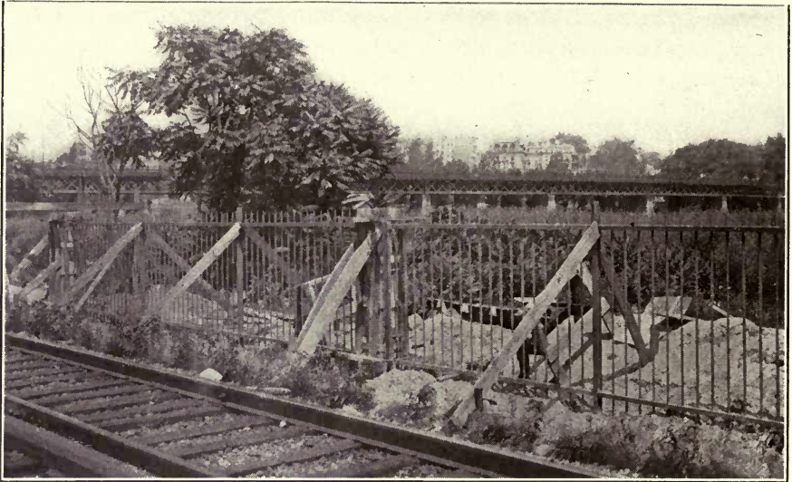
FIG. 151.—FORMS IN PLACE, FENCE POSTS, N. Y. C. & H. R. R. R.
