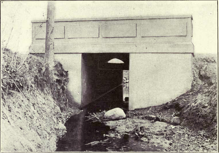
CULVERT, DUMONT, N. J.
