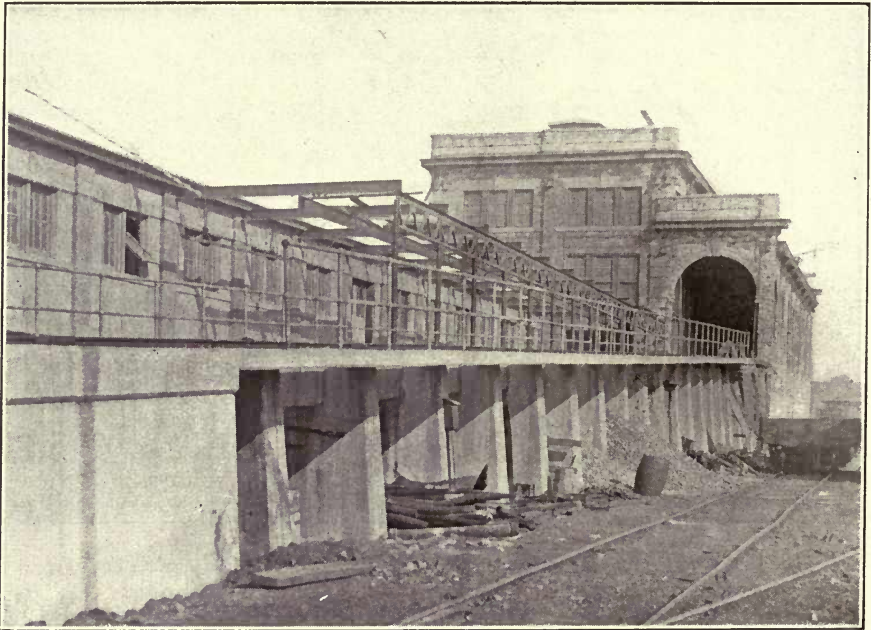
FIG. 83.—COAL TRESTLE, HOBOKEN, N. J., D., L. & W. R. R.
