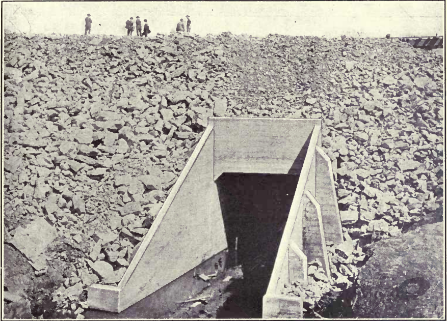
FIG. 42.—INDIAN CREEK CULVERT, K. C., M. & O. RY.
