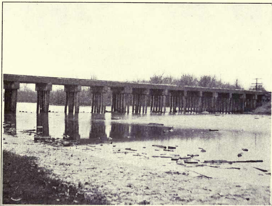
FIG. 22.—CONCRETE PILE TRESTLE, C., B. & Q. R. R.
