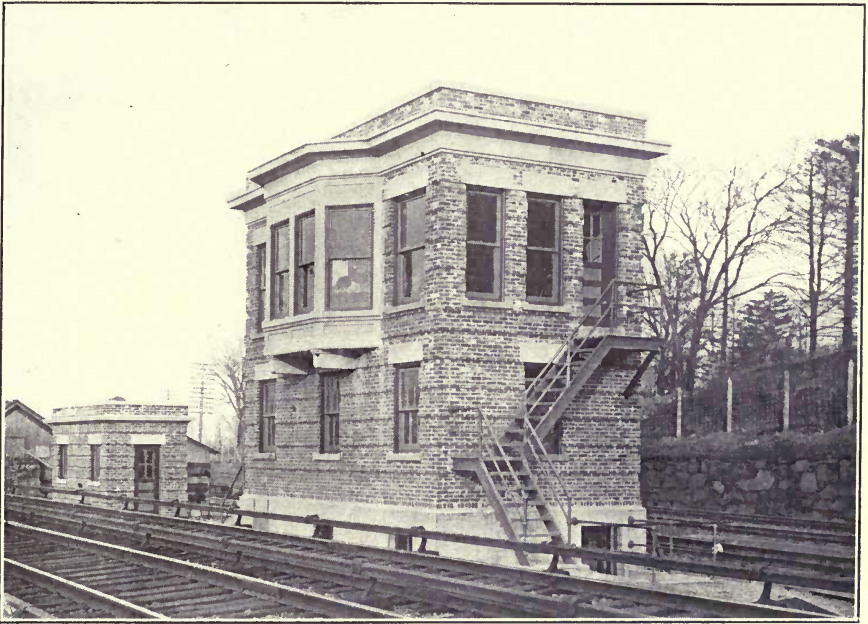
FIG. 95.—KINGSBRIDGE SIGNAL TOWER, N. Y. C. & H. R. R. R.
