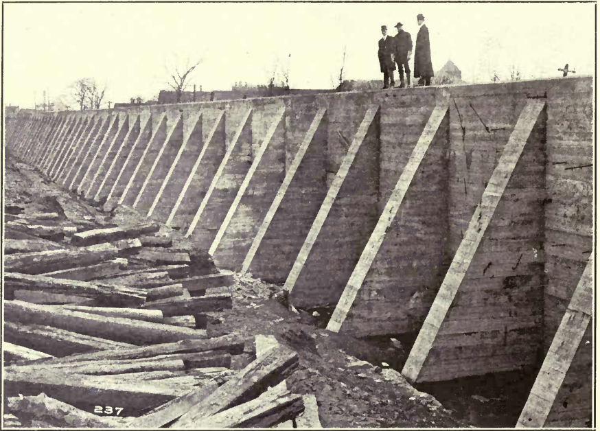
FIG. 64.—BUFFALO RETAINING WALL, D., L. & W. R. R.
