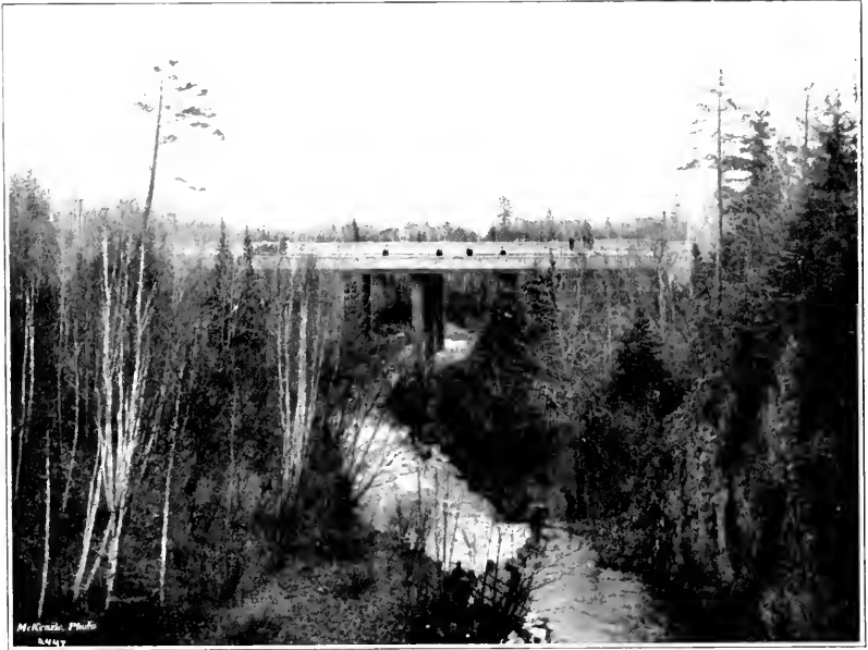
Tischers Creek Bridge, Duluth
