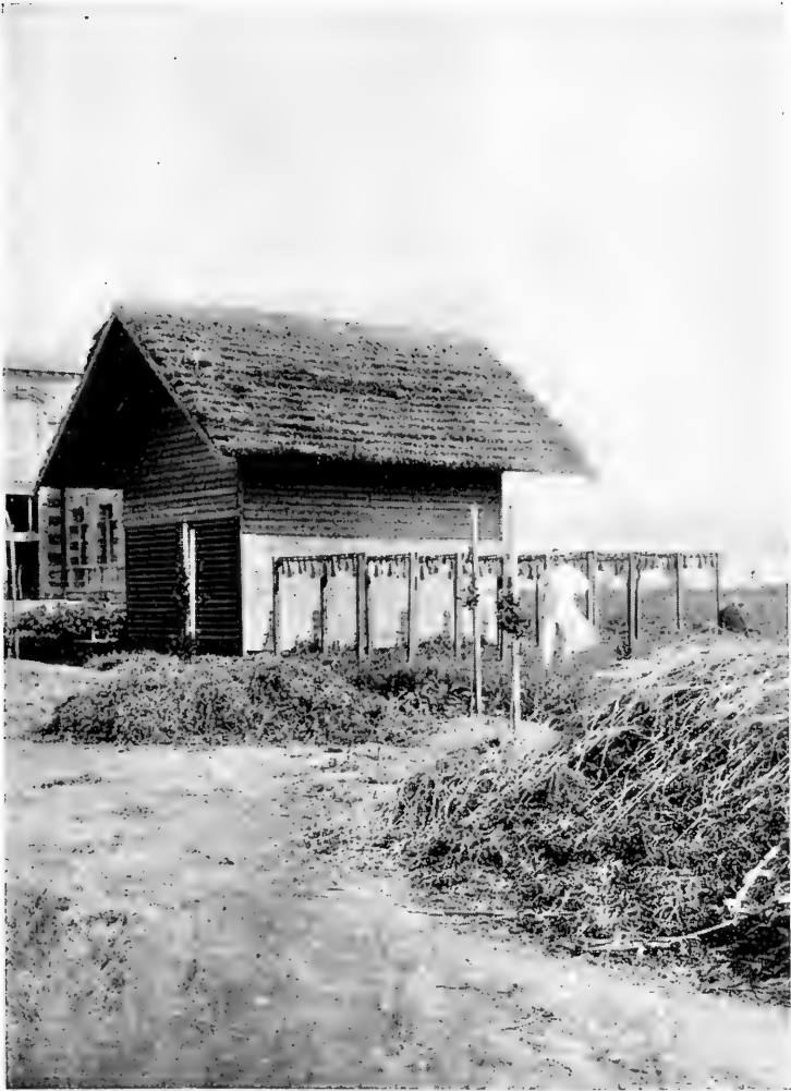
Fig. 25. — La sécherie et le dépôt montrant la face frontale munie d'une jalousie.
