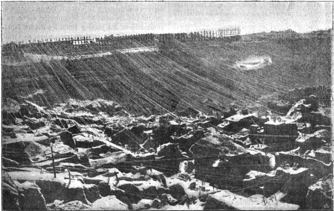
Vue des câbles transporteurs des différents claims dans la grande mine de Kimberley, il y a vingt ans.
