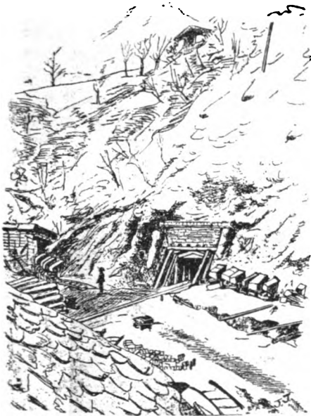
Entrée de la galerie de ventilation.
