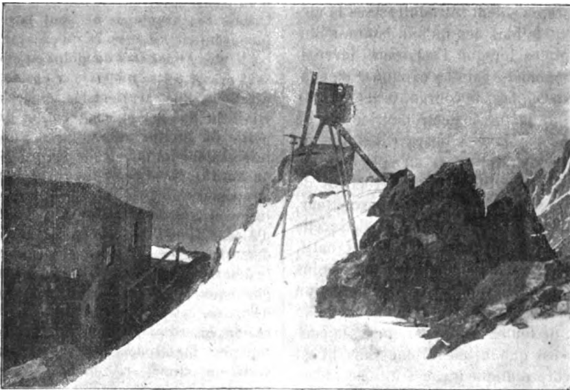
Fig. 5. — Poste disposé pour l'étude de l'électricité atmosphérique.
