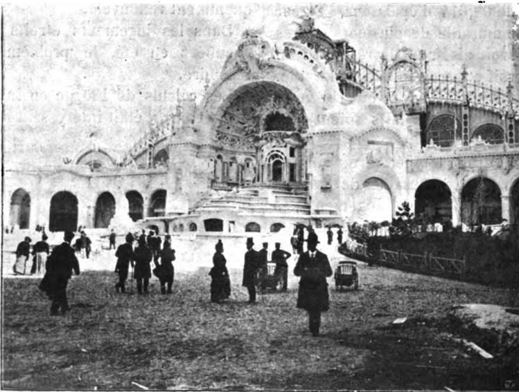
Le château d'eau.
