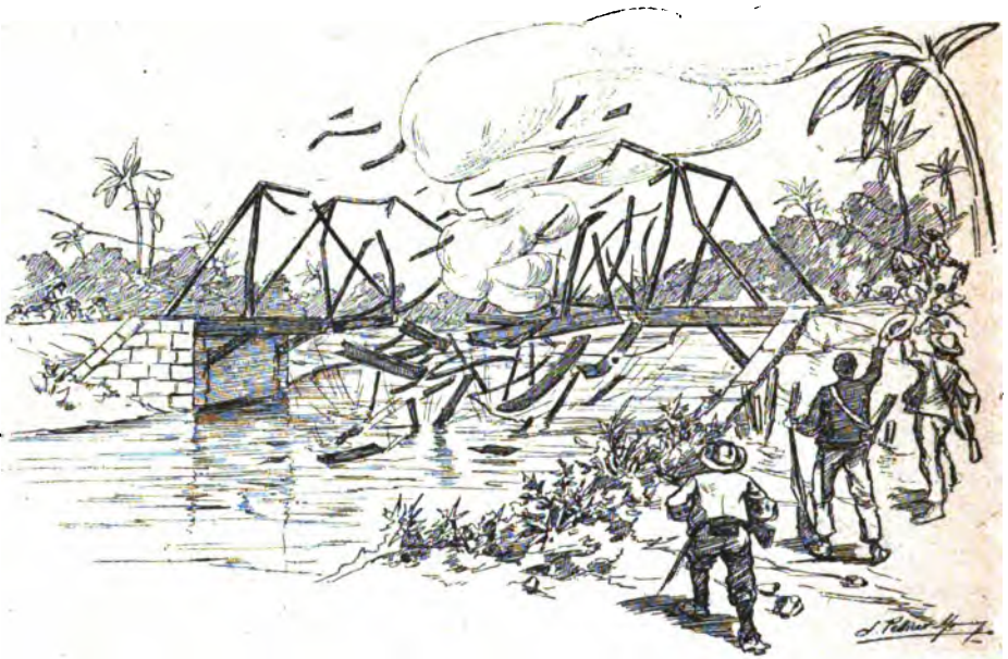
Voladura del puente de hierro sobre el río CamaJuaní.
