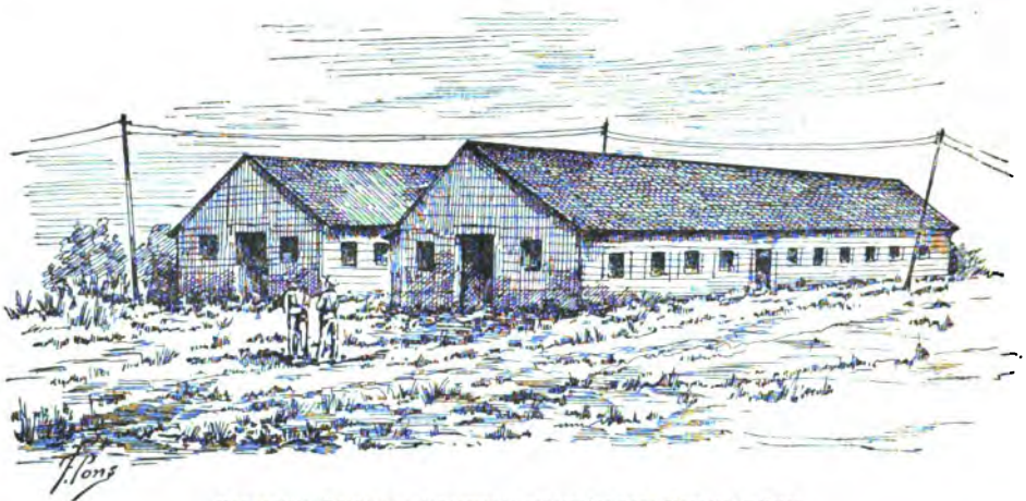
Manzanillo: Edificio recientemente construido para Hospital militar.
