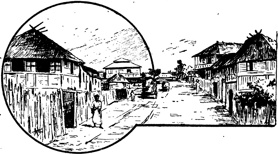
Cavite: Calle Carretera de Naguiló.
