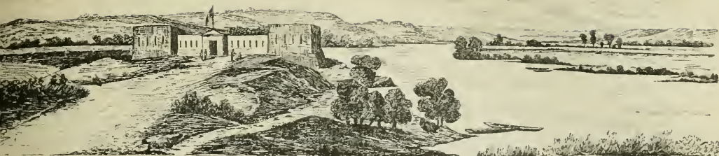
Fig. 102. — Fort de Lampsar sur le marigot de Khassak (Sénégal).
