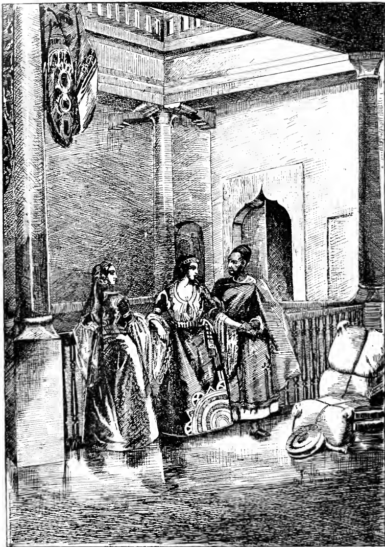
Fig. 257. — Intérieur d'une maison juive à Mogador. (D'après une aquarelle de Darondeau.)
