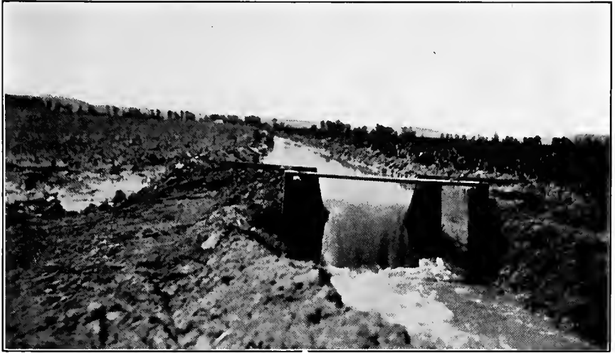
FIG. A.—Eighteen-inch Cippoletti Weir.
