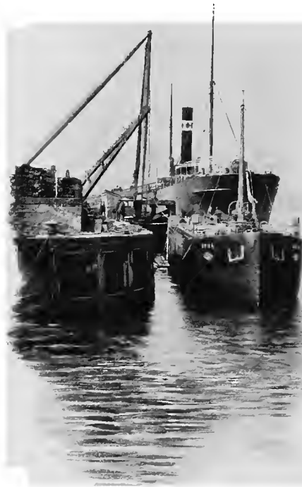
WEST JETTY AND SHEERLEGS.
