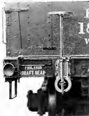
Figs. 5203-5204. Feasible Drop Brake Staff. U. S. Metal & Mfg. Co.
