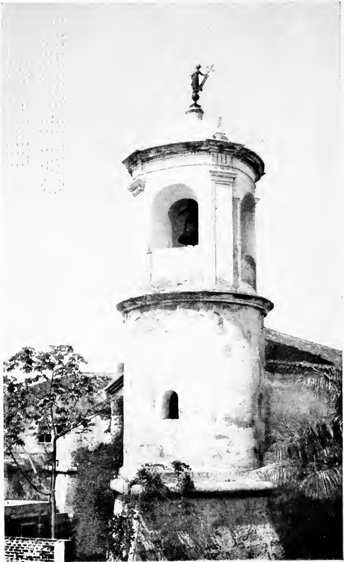
TOWER OF LA FUERZA Havana
