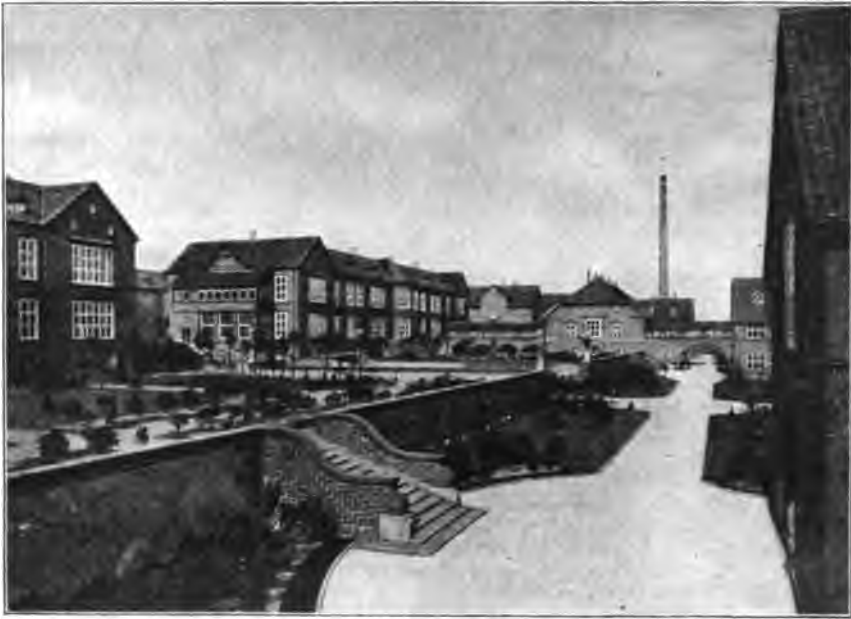
Bispebjerg Hospital: Sygebygninger med Haver. I Baggrunden østre Operationsbygning med Forbindelsesgange.
