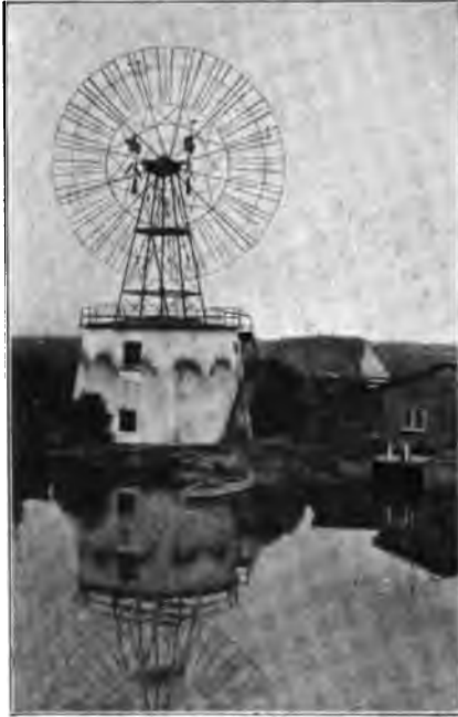
Fra de inddæmmede Arealer paa Syd- Lolland. Pumpeværk ved Billitz. (M. Lundbo fot.)
