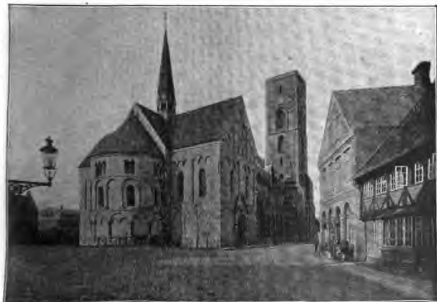
Ribe Domkirke. Til højre Weis'es Hus. (M. Lundbo fot.)
