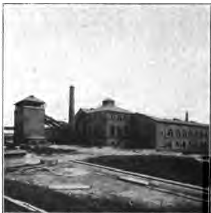
Valby Gasværk. (Fot.)
