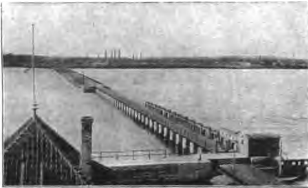
Dæmnings- og Sluseanlæg i Kalvebodstrand, set mod Frederiksholm. (Jul. Aagaard fot. 1906.)
