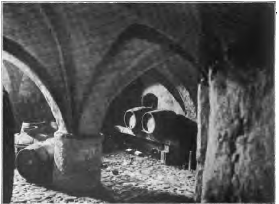
Bogense. Brænderigaardens Kælder. (H. M. fot.)
