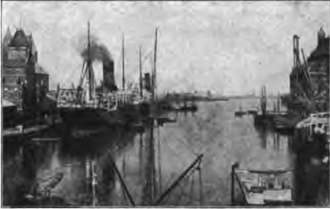
Vestbassinet i Frihavnen, set ud efter mod Indløbet. (Ingeniør Agerskov fot.)
