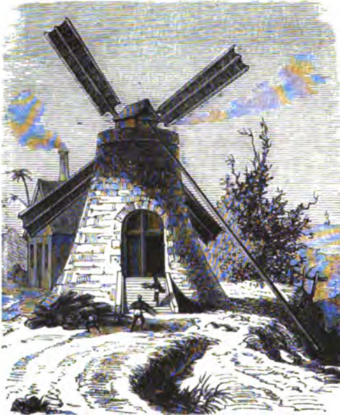
Fig. 87. Mühle zum Zerquetschen des Zuckerrohrs.
