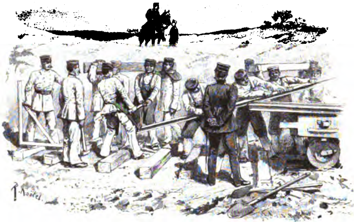
Das Eisenbahnregiment beim Eisenbahnoberbau.
