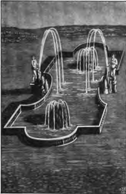
Bassin mit den Flußgöttern (im untersten Garten).
