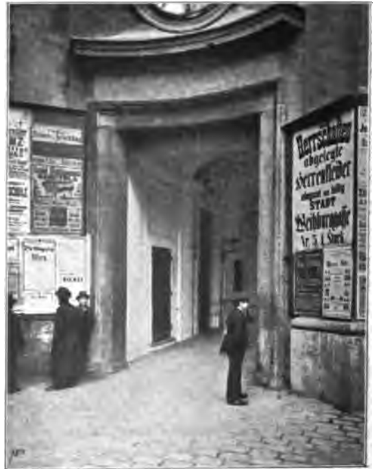
Abb. 164. Eingang des alten Burgtheaters.
