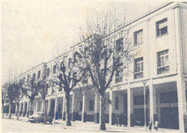
الواجهة الرئيسية لعمارة شارع الحسن الثاني بالمدينة الجديدة بفاس
