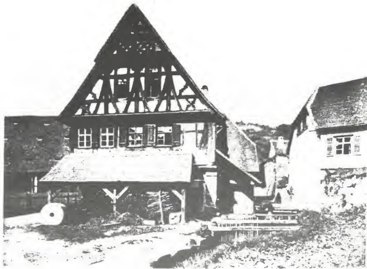
Gumpen- oder Spitalmühle im Hof des Spitals. Heute Altersheim.
