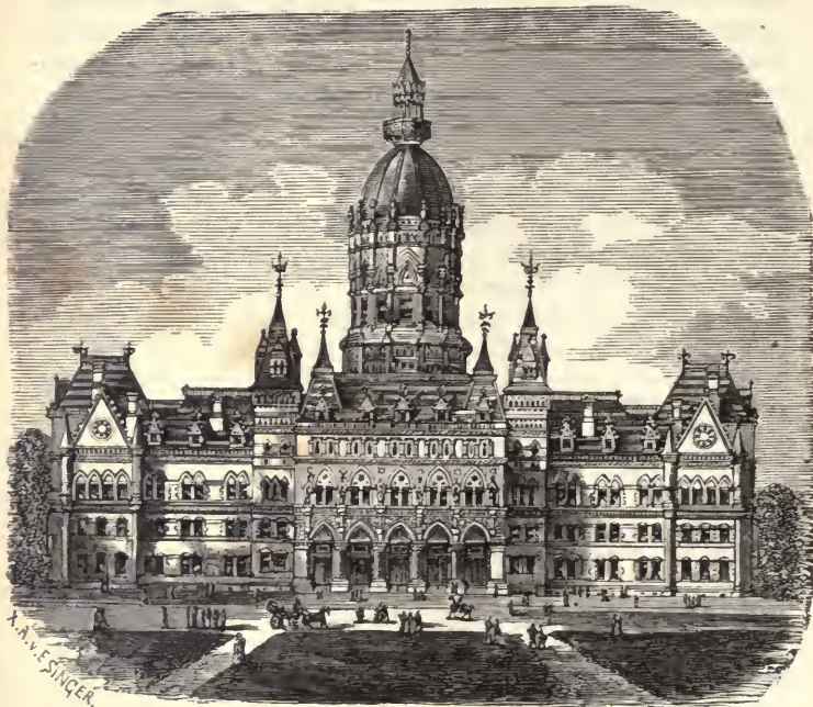
Das Regierungsgebäude von Connecticut
