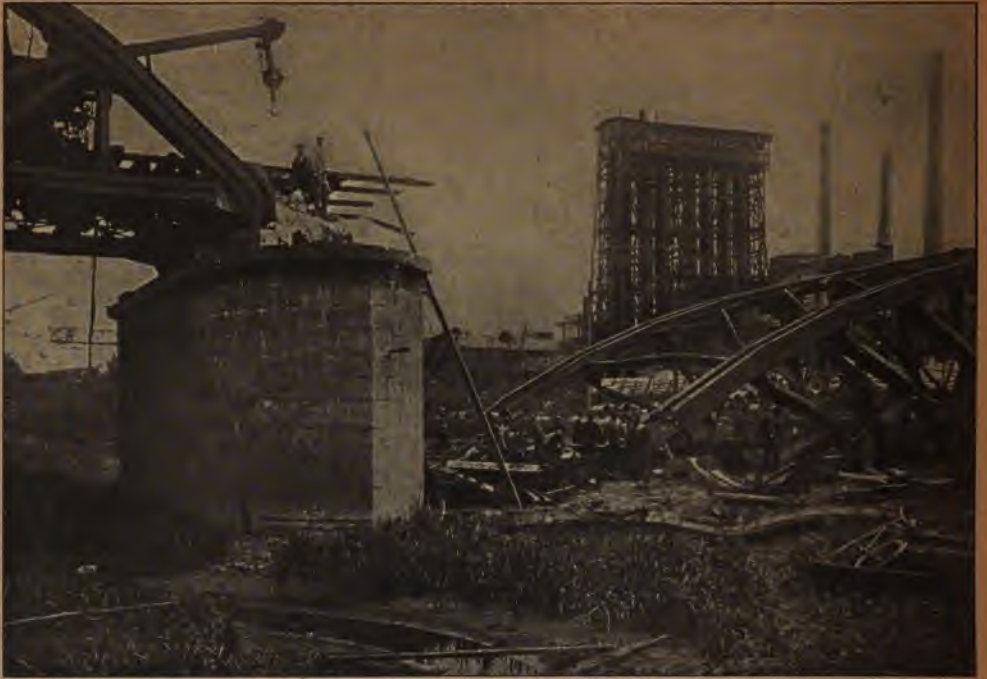
Von den Polen zerstörte Brücke bei Cosel-Oderhafen.
