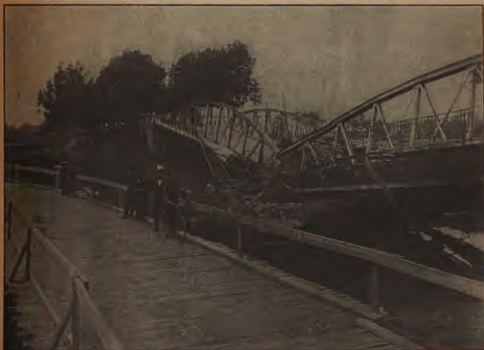
Von den Polen zerstörte Brücke bei Bogorzelleh.
