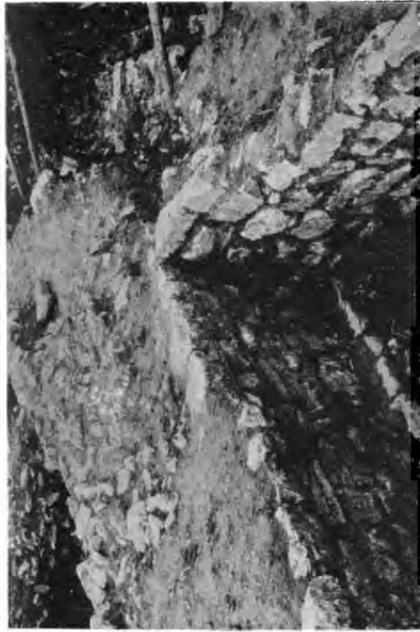
FIG. 2. ANSCHLUSS DES ANBAUS AN DIE OSTECKE DES UNTEREN KASTELLS.
