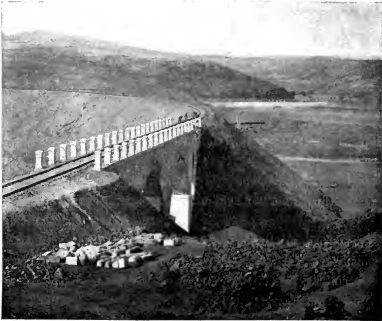
Steinbrücke der südlichen Mandchureibahn.
