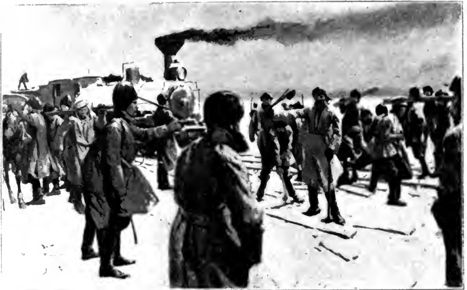
Eisenbahnbau auf dem Eise des Balkallees.
