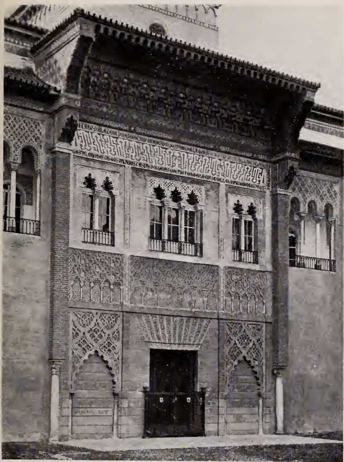
1. Sevilla, Alcazarfassade von 1364. (Phot. J. Roig)
