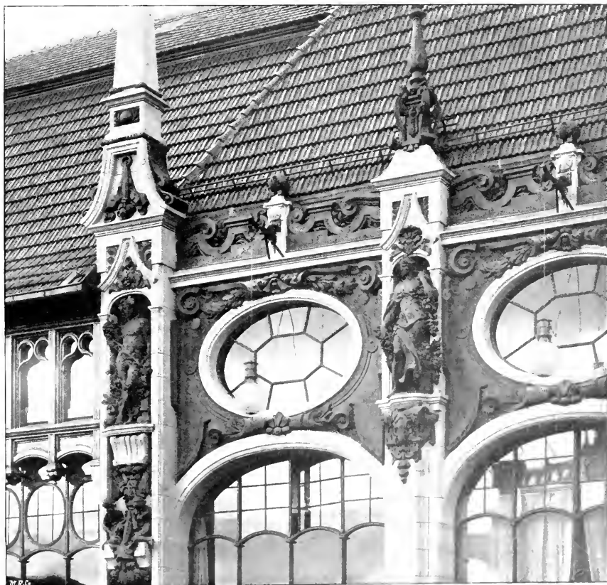
Detail der Fassade: Mittelbau
