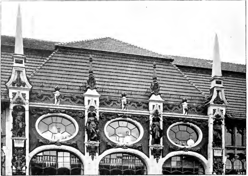
Detail der Fassade (Mittelbau).
