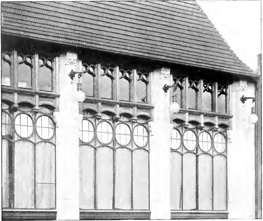
Detail der Fassade (rechter Seitenbau).
