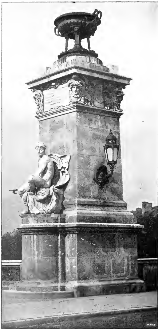
Pfeiler der Isarthor-Brücke—München. HERM. HAHN—MÜNCHEN.
