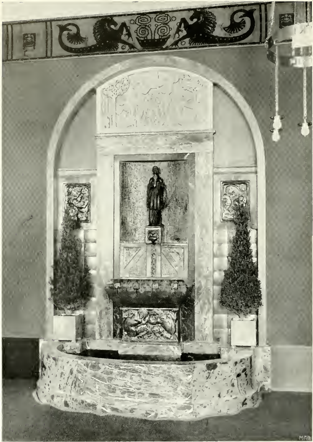
C. FRANCKE, W. BATTERMANN, A. HENNEBERGER—ALTONA. BRUNNEN IN EINEM WARTE- U. ERHOLUNGS-RAUM. Die musivischen Arbeiten ausgeführt von Puhl & Wagner—Rixdorf.
