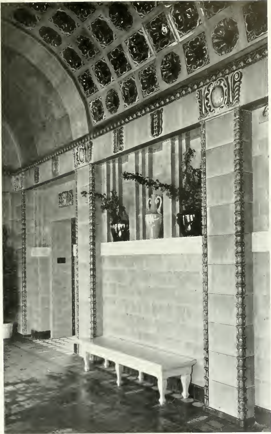
WAND-PARTIE IM WANDELGANG. AUSGEFÜHRT VON DEN KERAMISCHEN FABRIKEN VILLEROY & BOCH IN DRESDEN, MERZIG UND METTLACH.
