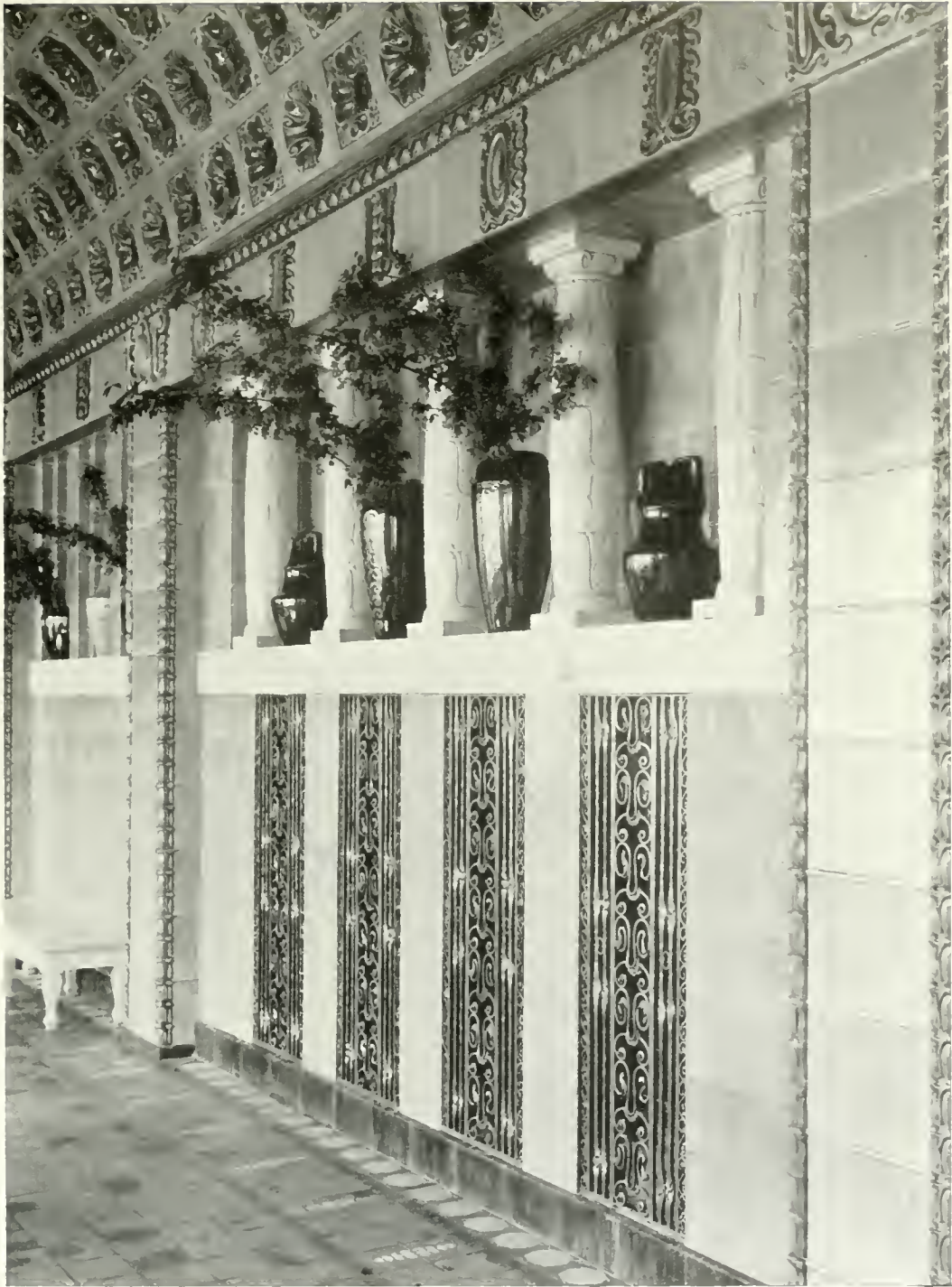
MITTEL-PARTIE MIT NICHE IM WANDELGANG. AUS- GEFÜHRT VON DEN KERAMISCHEN FABRIKEN VILLE- ROY & BOCH IN DRESDEN, MERZIG UND METTLACH.
