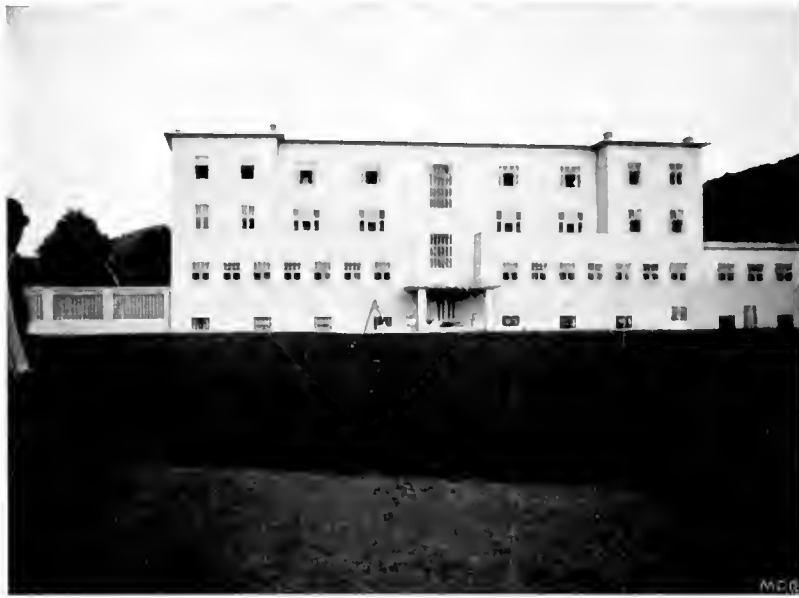
Sanatorium Purkersdorf bei Wien. Erbaut von der Wiener Werkstätte. Rückseite.
