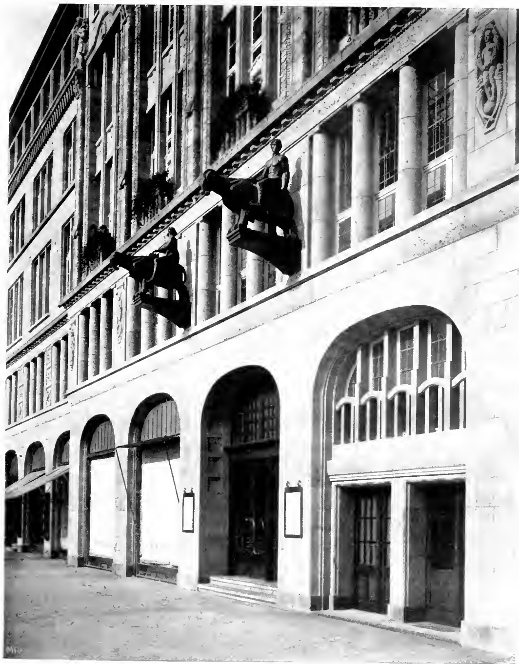
ARCHITEKT EMIL SCHAUDT: DETAIL DER ÖSTLICHEN FASSADE. PROFESSOR GEORG WRBA—BERLIN: BRONZE- UND STEIN-SKULPTUREN
