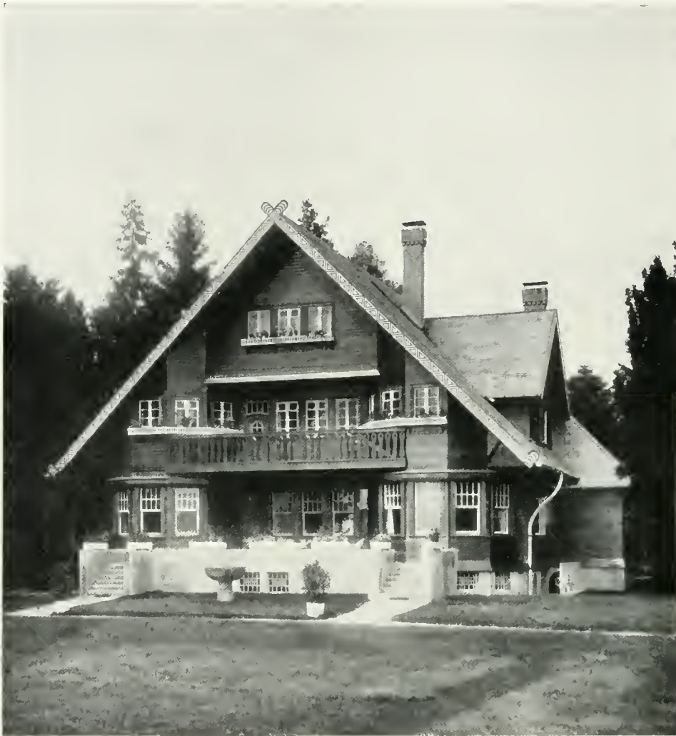
PROF. H. METZENDORF. LANDHAUS (HOLZBAU) DES GEH. RAT VOITH IN SCHACHAU AM BODENSEE.
