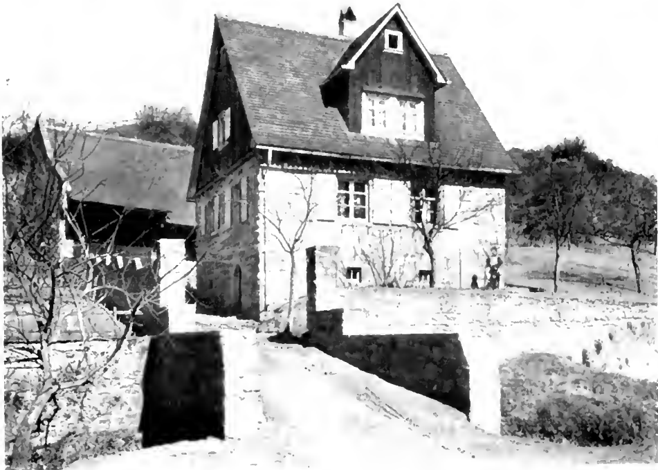
PROF. H. INR. MEIZENDORF. ARBEITER-HÄUSER DER FIRMA W. ELLER IM ELLER-TAL BEI BENSHEIM
