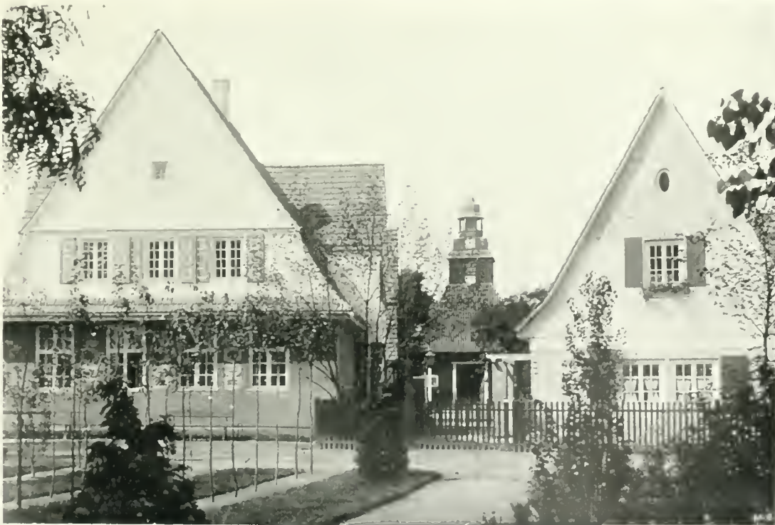
P. FISCHER POSEN. GEMEINDEHAUS (SCHULE) IM KLEINSIEDLUNGSDORF.
