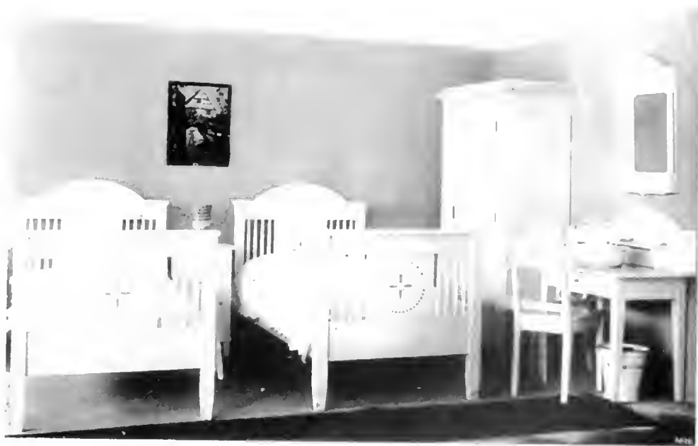
REG.-U. BAURAT P. FISCHER POSEN. SCHLAFZIMMER EINES ARBEITERHAUSES.
