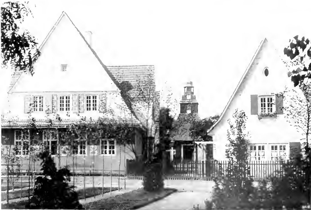
P. FISCHER POSEN. GEMEINDEHAUS (SCHULE) IM KLEINSIEDLUNGSDORF.
