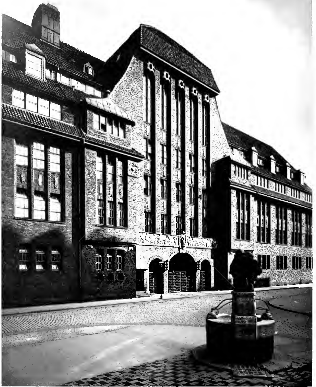
ARCHIT. K. SIEBRECHT HANNOVER. BILDHAUER PROF. GEORG HERTING. H. BAHLENS KFKS-FABRIK. «DER FABRIKBAU» GES.-AUSFÜHR: RIESLE & RÜHLING HANNOVER.
