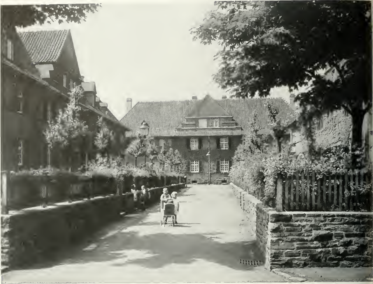
MARGARETHEN-HÖHE. »VIERHÄUSER-BLOCK AN DER SONNENBLICK-STRASSE«
