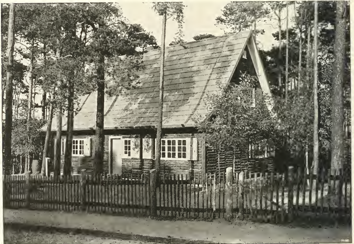
HELLERAUER HOLZHAUS. ZWEITES MODELL MIT AUSGEBAUTEM DACH. AUSGEFÜHRT VON DEN DEUTSCHEN WERKSTÄTTEN A.-G., HELLERAU.
