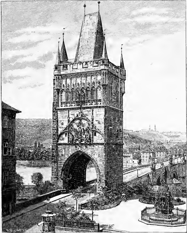
Fig. 74. Prag, Altstadt Brückenturm.
