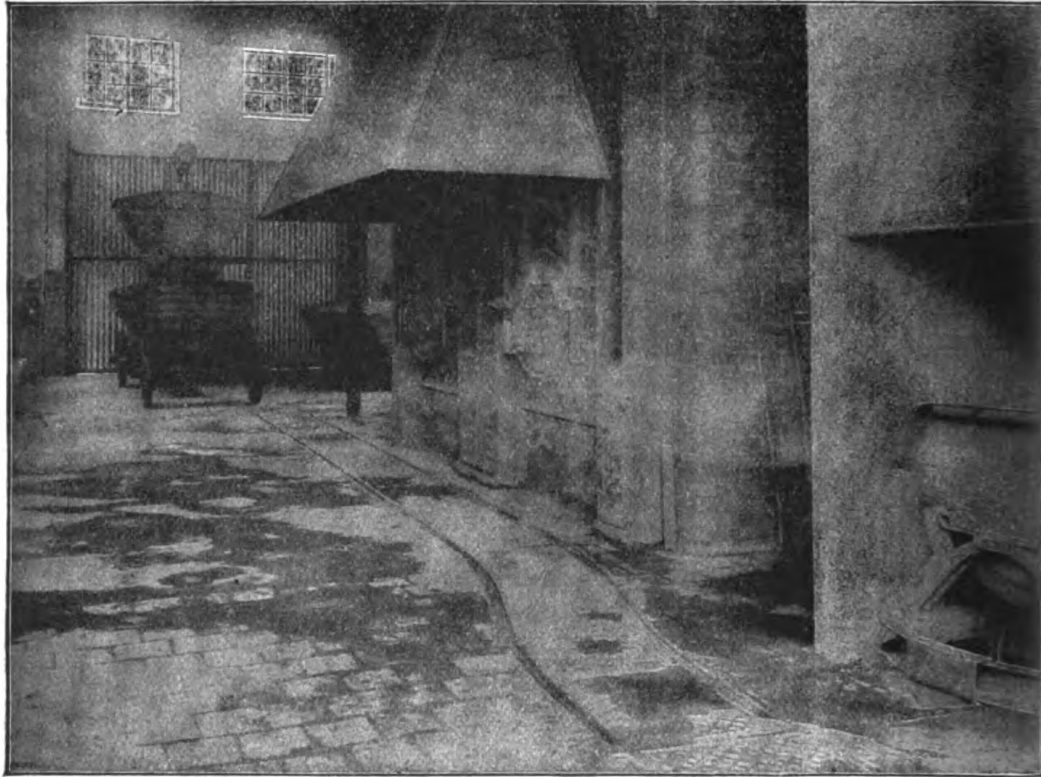
Entschlackungsflur mit Löschurm (rechts). (S. auch Fig. 6.)
