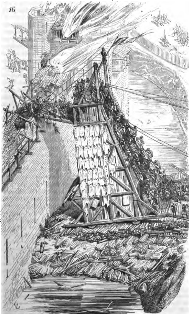
vains les efforts des assaillants pour monter d'un étage à un autre. Les
