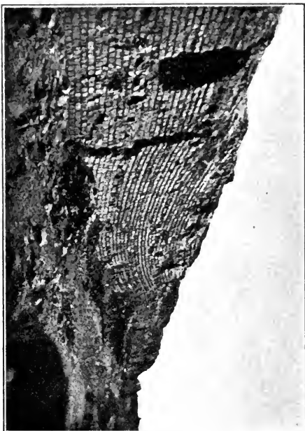
Unduliertes Backsteinmauerwerk zu Karnak 1).
