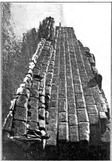
Unduliertes Fundamentmauerwerk mit Ausgleichschiecht zur Horizontalen zu Elné 1).
