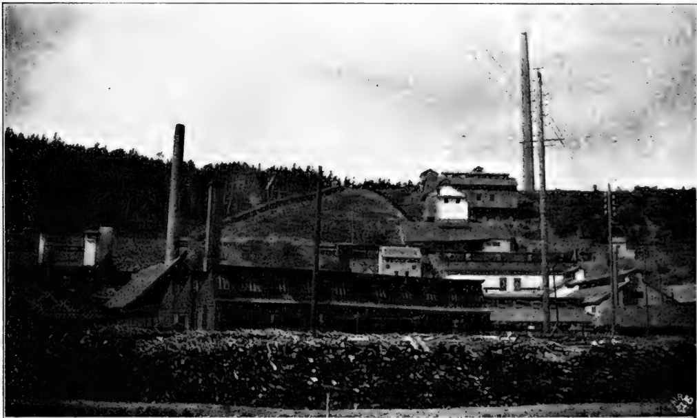
Fig. 13. Silberhütte vom Selkethal aus. Rechts wenig bewachsener Hang (siehe Fig. 14) mit der hohen Esse. Links beginnt zwischen den beiden Schornsteinen der Rauchkanal, der sich am stark beschädigten Waldrand zur Höhe hinaufzieht. In der Mitte des Kanals sieht man Rauch, der die undichte Stelle anzeigt.
