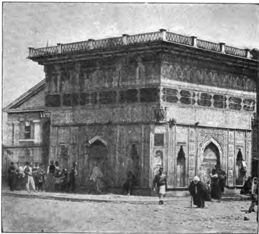
Fig. 23. Brunnenhaus in Topchané.
