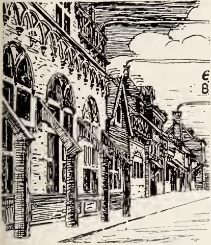
LÜTTICH, SUR LES REMPARTS, GOTISCHES HAUS
