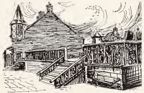
LÜTTICH, GOTISCHE TERRASSE
