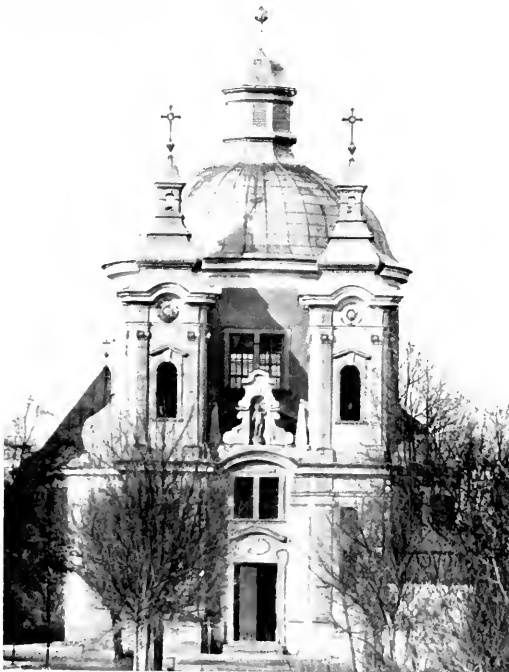
FASSADE DER WALLFAHRTSKIRCHE IN CHRISTKINDL Phot. Harter-Hart, Steyr. — Text nebenauf
