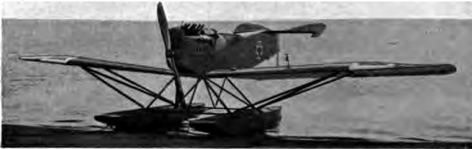
Abb. 100. Hanfa-Brandenburg-Seekampfeindecker-Einzieher mit 150 P. S.-Benzmotor.
