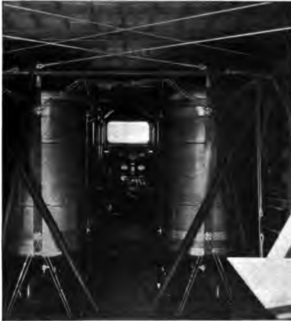
Abb. 91. Benzintankanlage zu Abb. 87. Für etwa zehnstündigen Betrieb fassen zehn bis zwölf derartige Kessel etwa 3000 l. Aus ihnen, im Rumpf gelegen, wird das Benzin zu den Motoren hingefogen. Die großen Mengen hochexplosiven Brennstoffes in Verbindung mit den langen Leitungen bilden für die R-Flugzeuge bei Unfällen eine gewisse Gefahr, der die nächste Entwicklung abhelfen wird.
