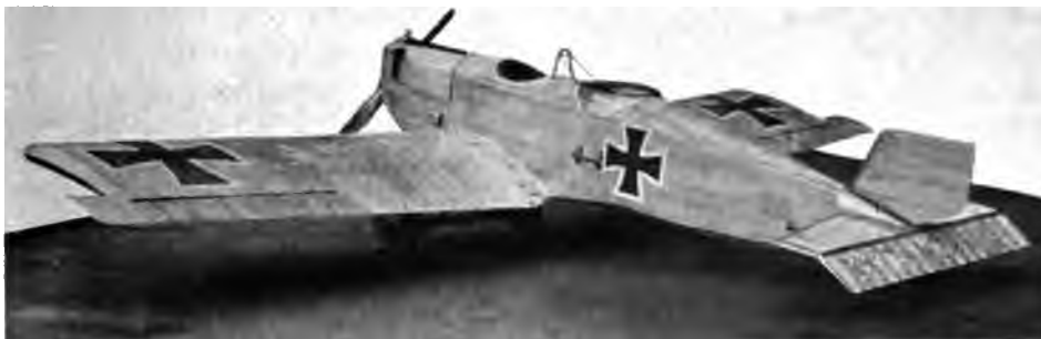
Abb. 64. Junters-Fokker CL I (s. Tab. I, Nr. 12). Ganzmetallflugzeug, sogen. Tiefdecker mit hervorragend freiem Gesicht- und Schußfeld. Verspannungslos.
