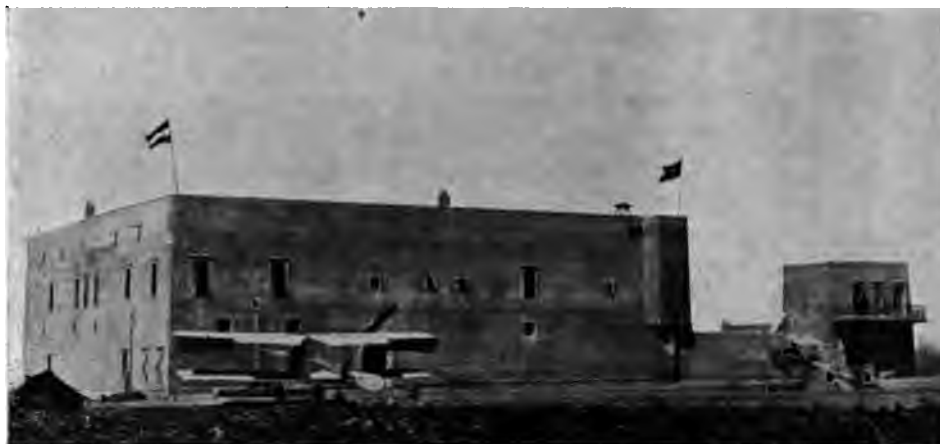
Abb. 278. Das Hauptgebäude („Han“) im Park von Mosul.
