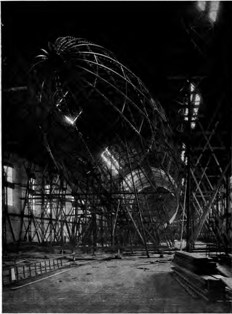
Abb. 25. Marine-Luftschiff S. L. 3 im Bau in Mannheim-Rheinau. Blick auf das im Gerippe fertige, noch nicht mit der Außenhülle bekleidete Vorschiff. Der Verlauf der Längsträger und Querringe gut erkennbar; um das Schiff herum Baugerüste.
