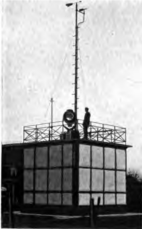
Abb. 219. Aufstellung des Bodenmessers (Steffens-Hedde) im Scheinwerferturm.
