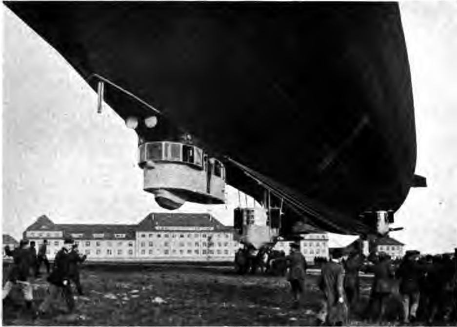
Abb. 34. P. L. 72 Aufnahme von vorn. Haltemannschaften mit Halteseilen; vorn die Führergondel, dahinter die vordere, untere Motorengondel, rechts die Backbordsteuer gondel.
