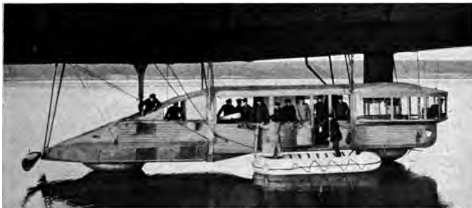
Abb. 16. Führergondel des L. Z. 72. Erprobung eines Floßbootes. Mittlerer Gondelteil („Aufenthaltsraum“) fiel später fort; Gondel dadurch kürzer und leichter; unter der Gondel vorn und hinten zwei Landungspuffer.
