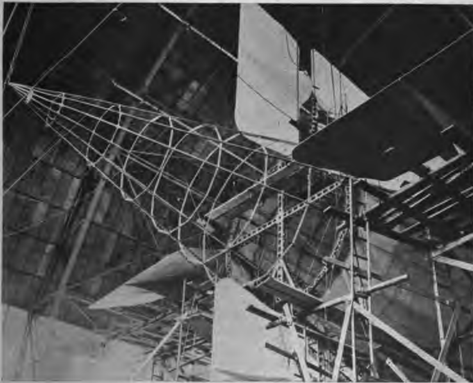
Abb. 27. S. L. VIII. Ansicht des Hecks während des Baues.
