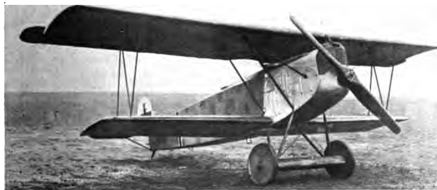
Abb. 69. Fokker D VII (s. Tab. II, Nr. 29). Verpannungsloser Einstieler. Stirnfühler.
