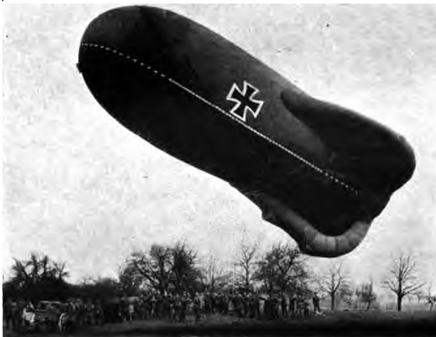
Abb. 3. AE-Ballon (850 cbm) zum Aufstieg bereit (nachgebaut nach dem französisch-englischen System Claquot-Caco).
