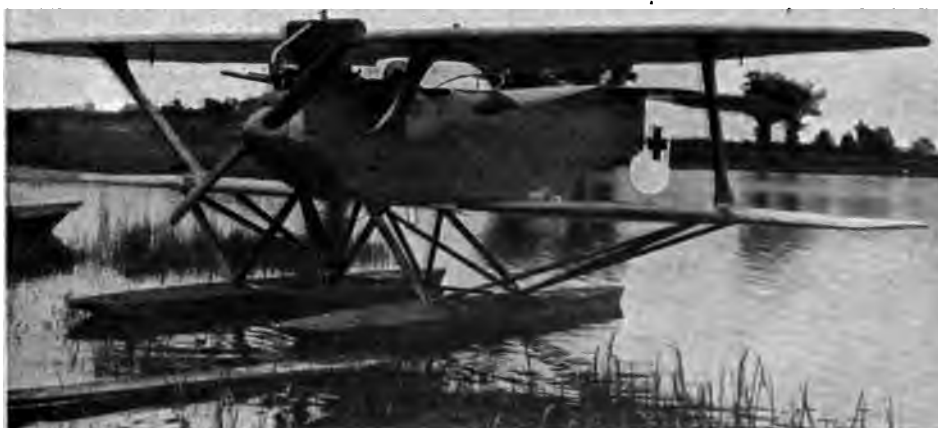
Abb. 101. Einzieltiger, verspannungsloser Hanfa-Brandenburg-Seekampf-Doppelsitzer.
