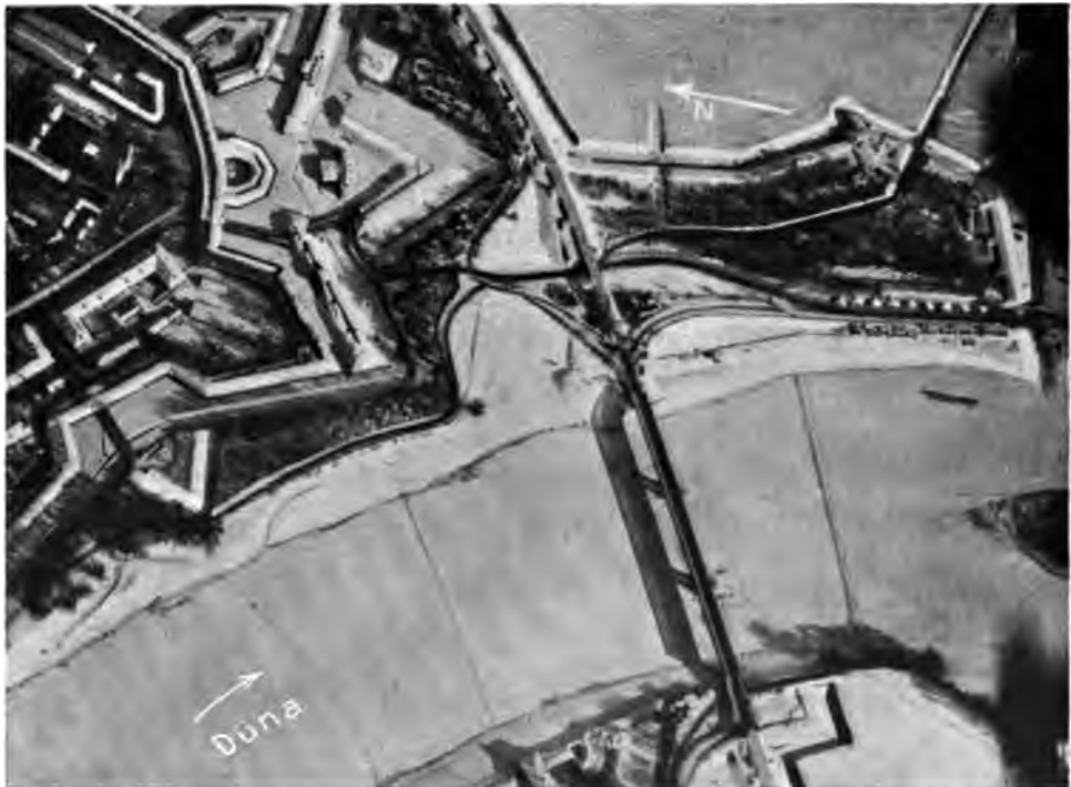
Abb. 128. Schrägaufnahme der Festung Dünaburg; Duna zugefroren. Brückenkonstruktion am Schatten erkennbar.
