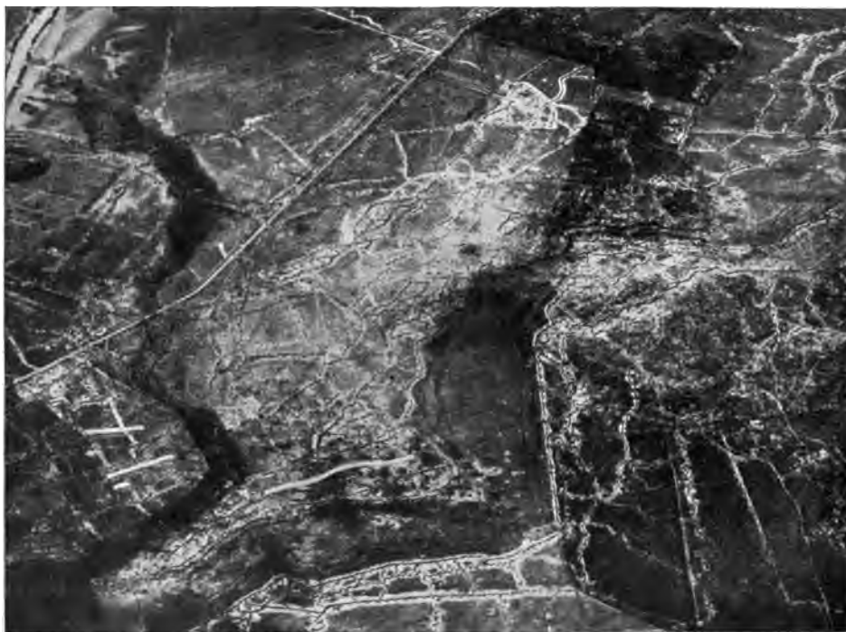
Abb. 246. Infanteriestellungen; Grabenhorn bei La Ville aux Bois, 10 Tage vor dem feindlichen Infanterieangriff. Beginn des Baues von Bereitstellungsgräben (6. April 1917).
