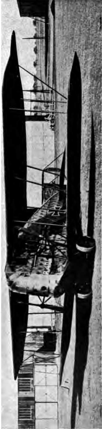
Abb. 84. Lintz-Hofmann R I. Ein Versuchsflugzeug aus dem Jahre 1916 mit zentraler Motorenanordnung und sehr niedrigem, einfachem Fahrgestell.
