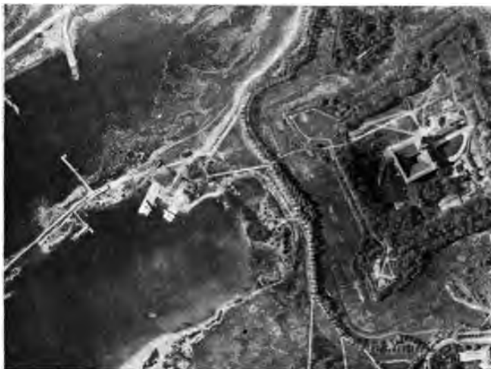
Abb. 285. Russische Seeflugstation Arensburg auf Osel nach der Zerstörung.
