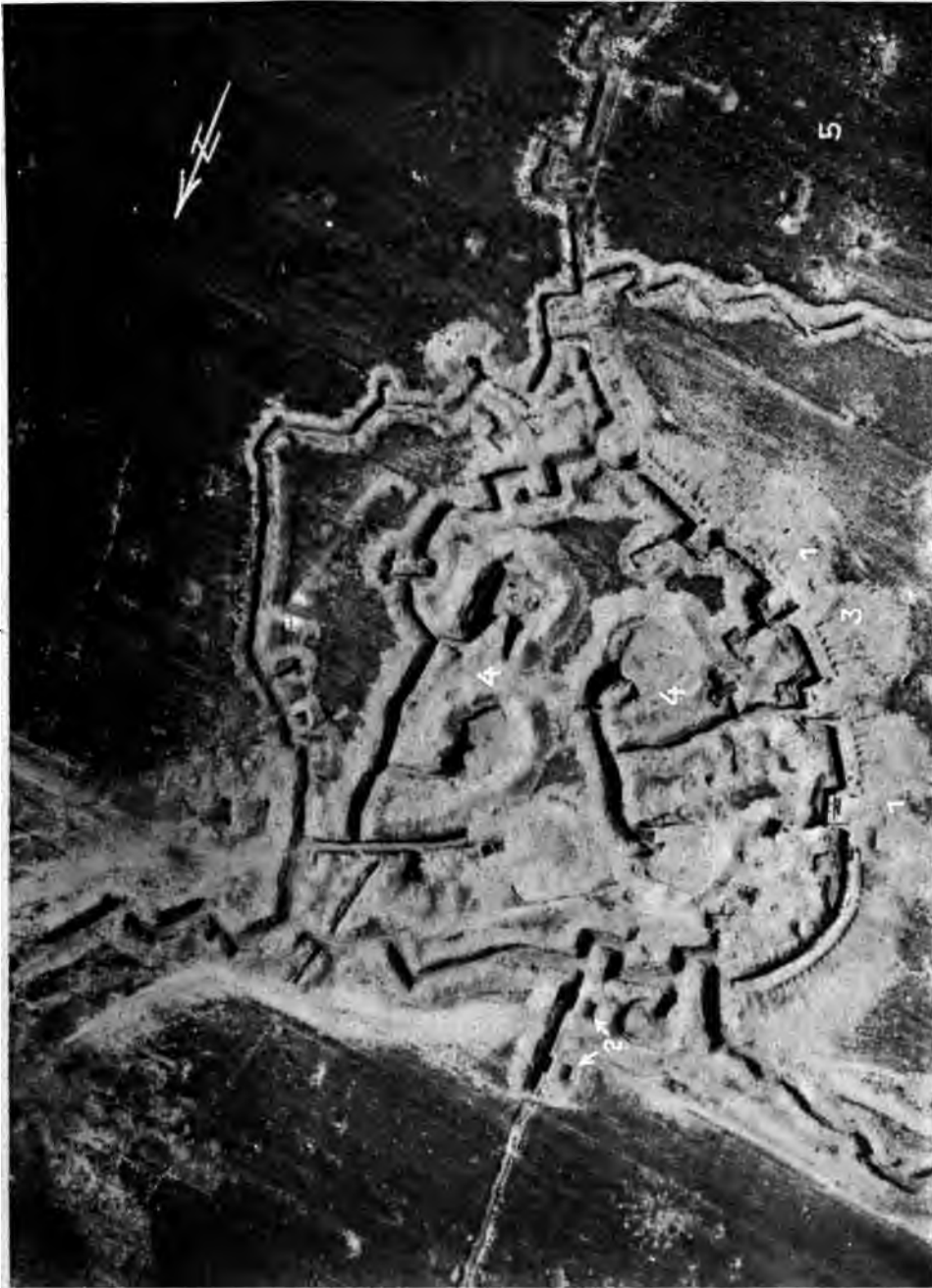
Abb. 137. Beispiel für Zielertundung mit 120 cm Brennweite. Das feindliche Erdwerk in allen Einzelheiten erkennbar: Bei 1 M. G.-Stand, erkennbar am Auschußfeld; 2 Minenwerferstand, niedrige Auschußöffnung; 3 Schießscharten; 4 Unterstände; 5 Pfähle des Drahthindernisses.
