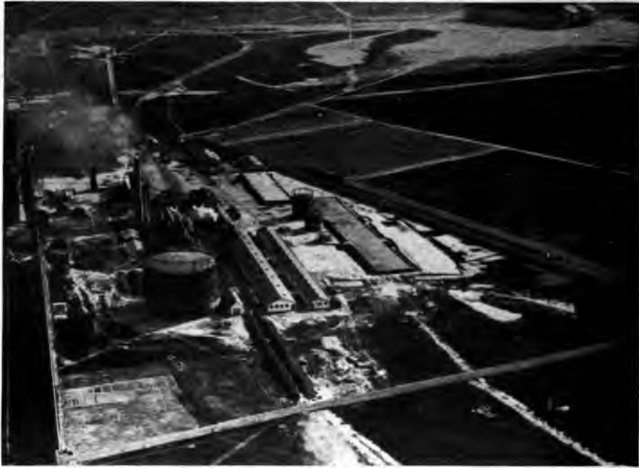
Abb. 41. Gesamtansicht der Wasserstoffgas-Anstalt Nordholz mit Gasometer und unterirdischen Gasochdrucklagerungen.
