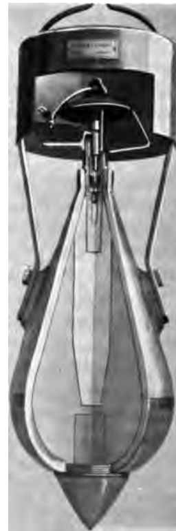
Abb. 196. Konstruktions- und Modellchnitt durch die 10- bzw. 20 kg-Carbonitbombe.
