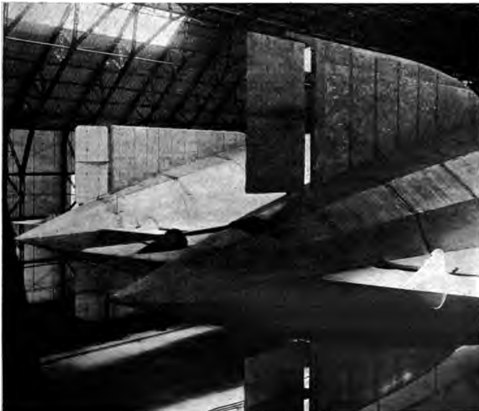
Abb. 21. Bild auf das Hinterchiff zweier Zeppelinluftschiffe mit wagerechten und senkrechten Dämpfungsflächen, Höhen- und Seitensteuern.
