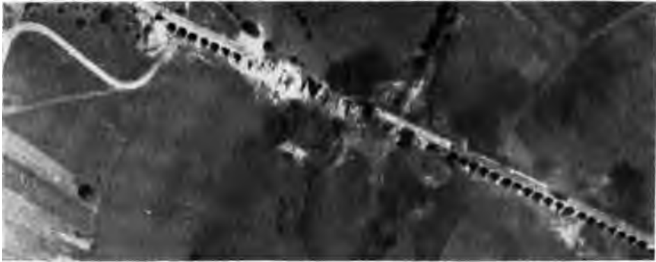
Abb. 261. Eisenbahnviadukt westlich Dammerkirch, im August 1914 von den Franzosen gesprengt.
