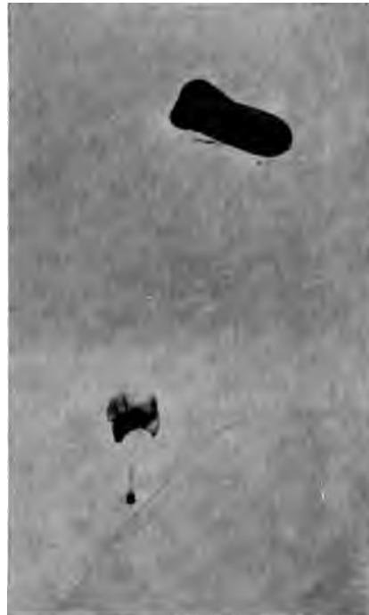
Abb. 172. Der Korbfallschirm nach 60 bis 70 m Fall kurz vor der völligen Entfaltung.
