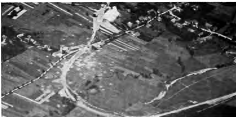
Abb. 265. Umgebungsbahn bei Dammertirch nach der Beschädigung durch zwei 21 cm-Mörser.
