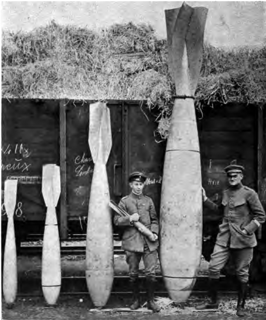
Abb. 199. P. und W.-Bomben. Von links nach rechts: 50, 100, 300, 12,5, 1000 kg.
