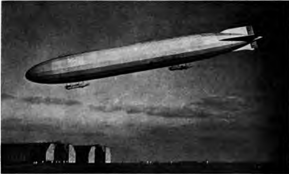
Abb. 8. Marineluftschiff L. 15 vor der Landung. L = 163,5 m, D = 18,71 m, Gasraum = 31 900 cbm, Geschwindigkeit = 26 m/sec. Vorn eine Führergondel mit Aufenthaltsraum und anschließender Motorgondel; hinten eine Dreimotorgondel mit zwei seitlichen in Böden gelagerten und einer unmittelbar angetriebenen hinteren Schraube; vorn auf dem Schiffsrücken Maschinengewehre.
