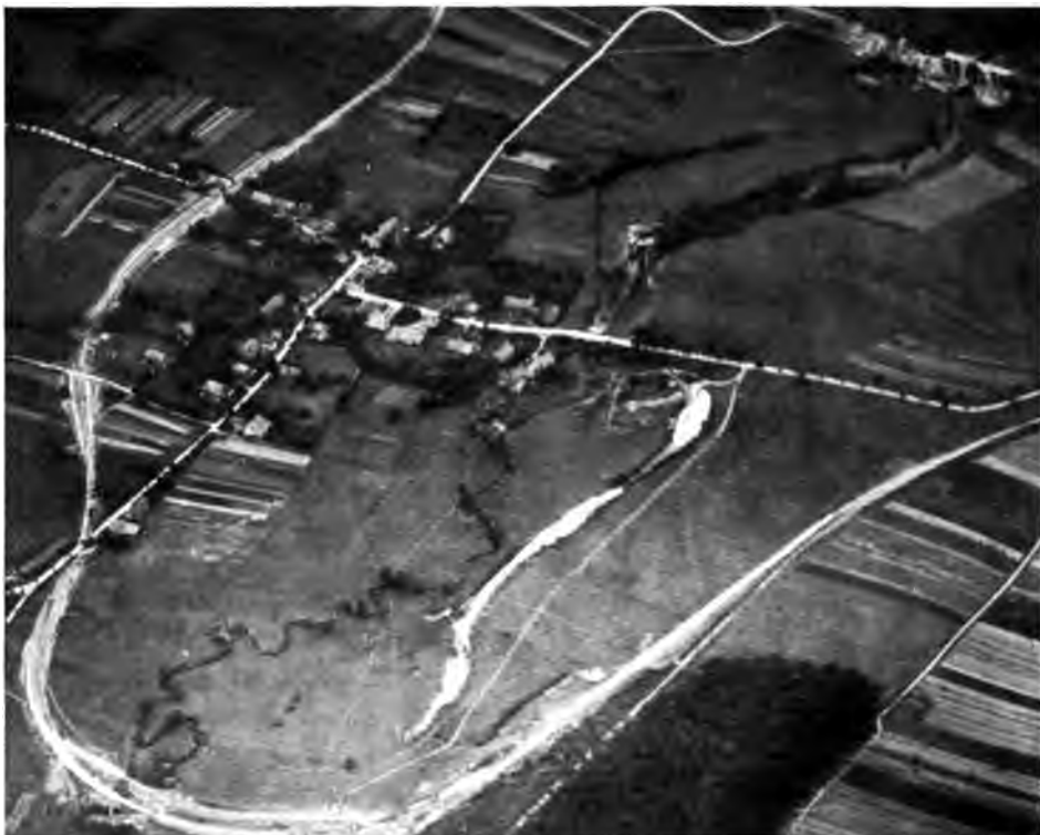
Abb. 264. Umgebungsbahn um den wieder eingeschossenen Viadukt bei Dammertirch.
