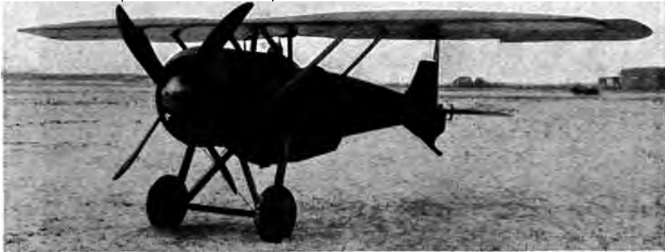
Abb. 72. Siemens-Schudert DVI (s. Tab. II, Nr. 36). Spannungsloser Hochdecker. Umlaufmotor. Der unterhalb des Rumpfes sichtbare Benzintank ist bei Brandgefahr abwerfbar. Im Sommer 1917, im Entwurf bereits fertig, fand dieser weit überlegene Typ damals leider keinen Eingang. 1918 endlich in seinen überragenden Eigenschaften erkannt, konnte er vor November 1918 nun nicht mehr an die Front und zur Wirkung kommen.
