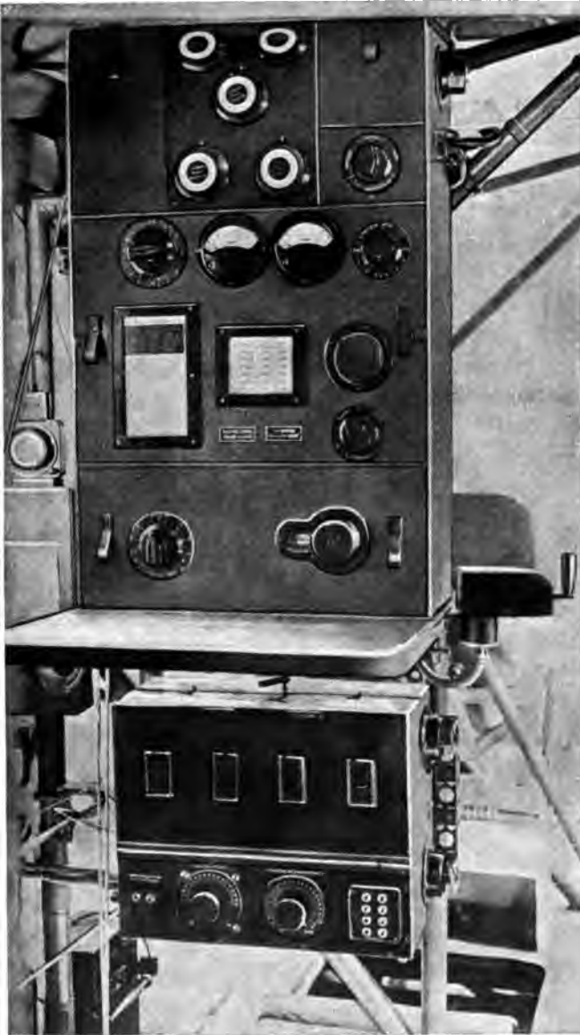
Abb. 161. Sender-Empfänger im Riesenflugzeug. (Telefunken, neuere Ausführung.)
