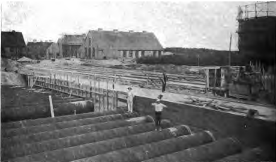
Abb. 42. Gasochdrucklagerungen des Marineluftschiffplatzes Ahlhorn im Bau. Die Gasessel von 16 m Länge, 900 mm innerem Durchmesser, 40 mm Wanddicke und 1000 cbm Gasinhalt bei 100 Atm. Druck sind auf festen Fundamenten nebeneinander verlegt. Sie werden später mit einer Erdschicht überschüttet (siehe auf dem Bilde links); rechts auf dem Bilde ein 30 000 cbm-Gasometer; im Hintergrund Baulichkeiten der Gasanstalt.
