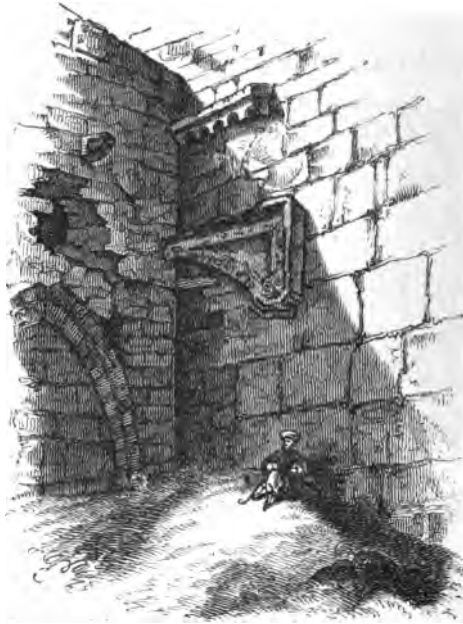
Vermauerte Huldapforte unter der Aksa.
