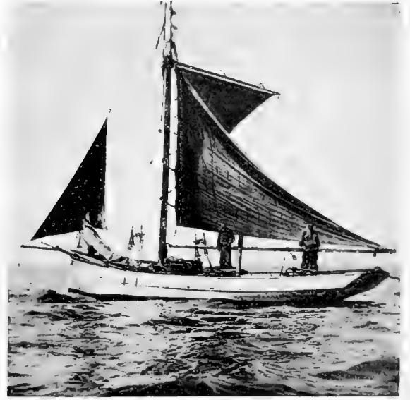
Fig. 14. Süder Piep. Garneelenkutter von Büsum mit der Kurre am Grund.
