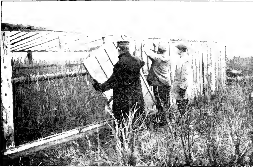
Flieder-Spättreiberei durch Errichtung von Nothäusern. Bild 1. Die Errichtung des Gewächshauses.
