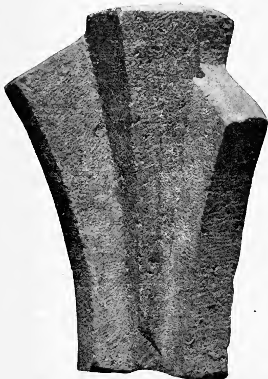
Abb. 5. Gewölbeansatz in der Baldachinecke.
