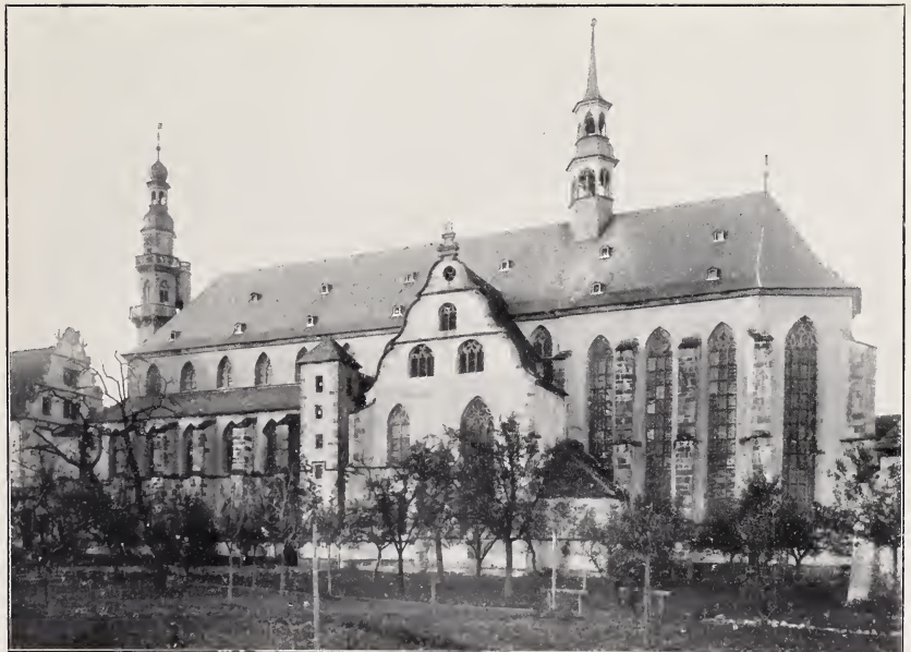
b. Molsheim. Dreifaltigkeitskirche. Äußeres.
