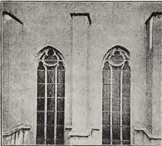
Bild 18. Bonn. Namen-Jesukirche. Bildung des Fenstermaßwerkes und der Strebepfeiler.
